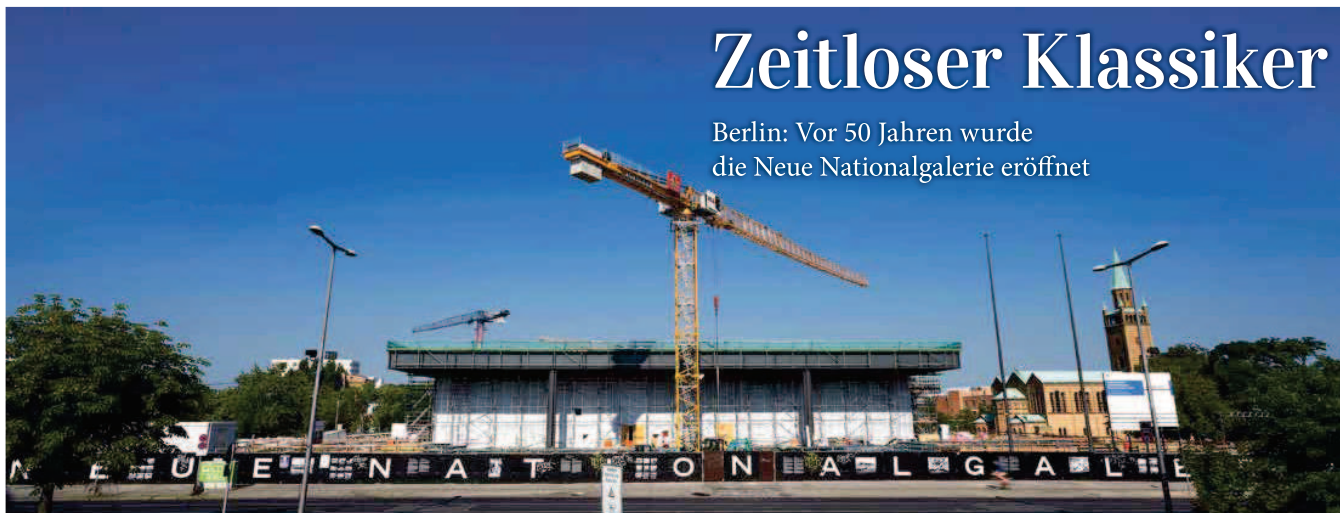
Baustelle der Neuen Nationalgalerie, Berlin
